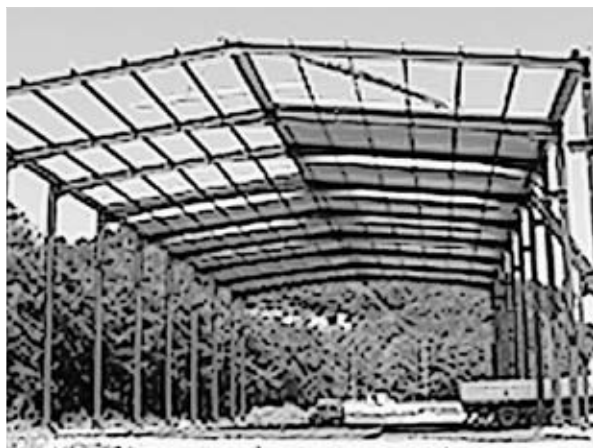
Estructura metálica realizada por Hermanos Bellido. | LNE
